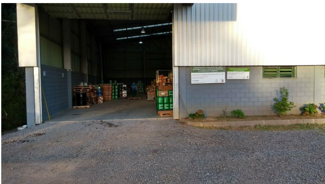
Figura 02: Depósito da Luparco em Garibaldi/RS
