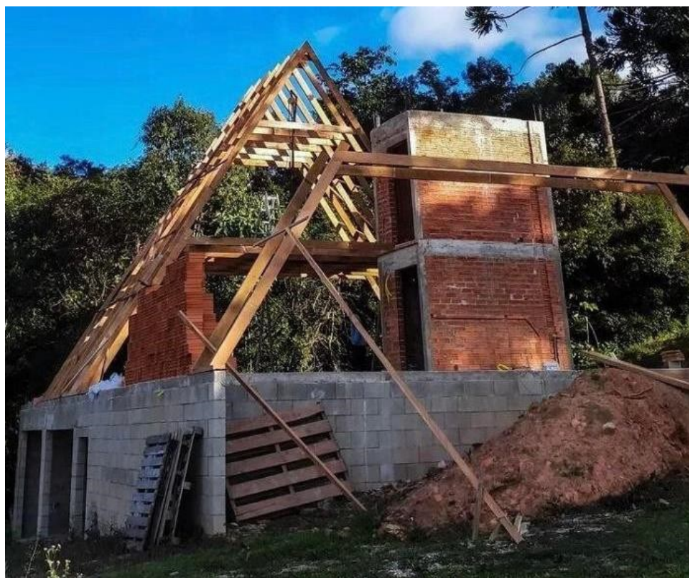
Figura 65– Levantamento da estrutura
