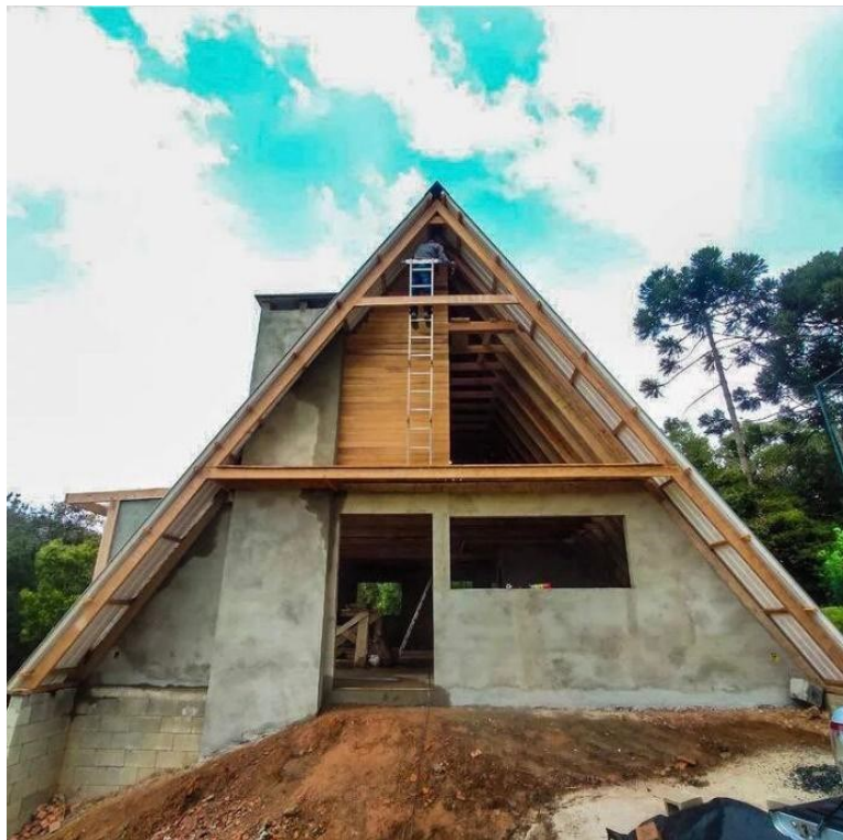
Figura 68– Fase atual (setembro/2022) início da instalação dos revestimentos da fachada
