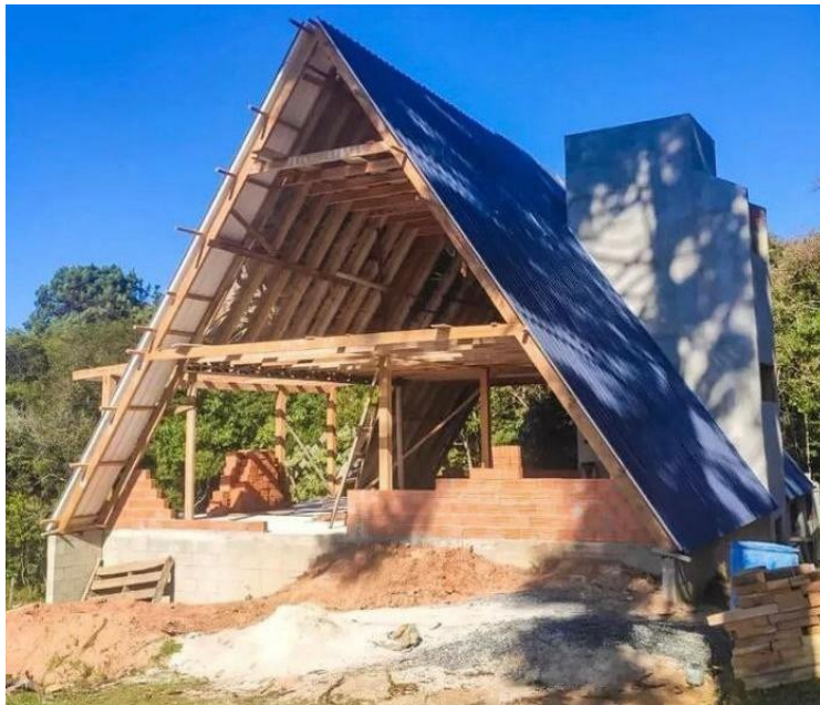
Figura 66- Instalação da cobertura
