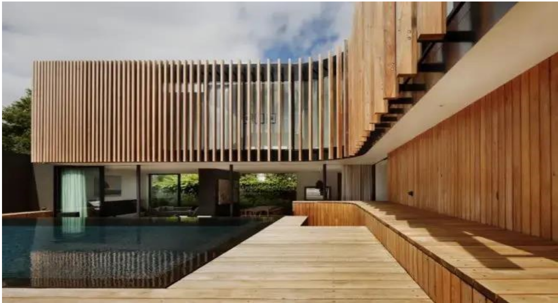
Figura 9 – Elementos de controle – Brise vertical externo
