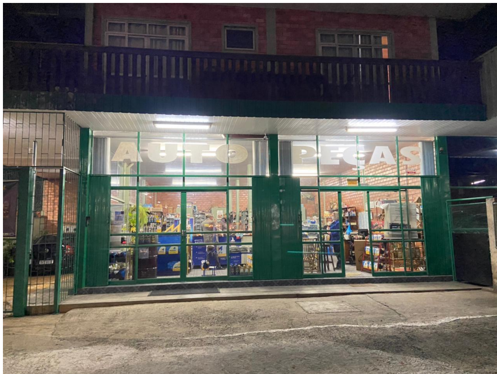
Figura 19 - Fachada atual da Autopeças
