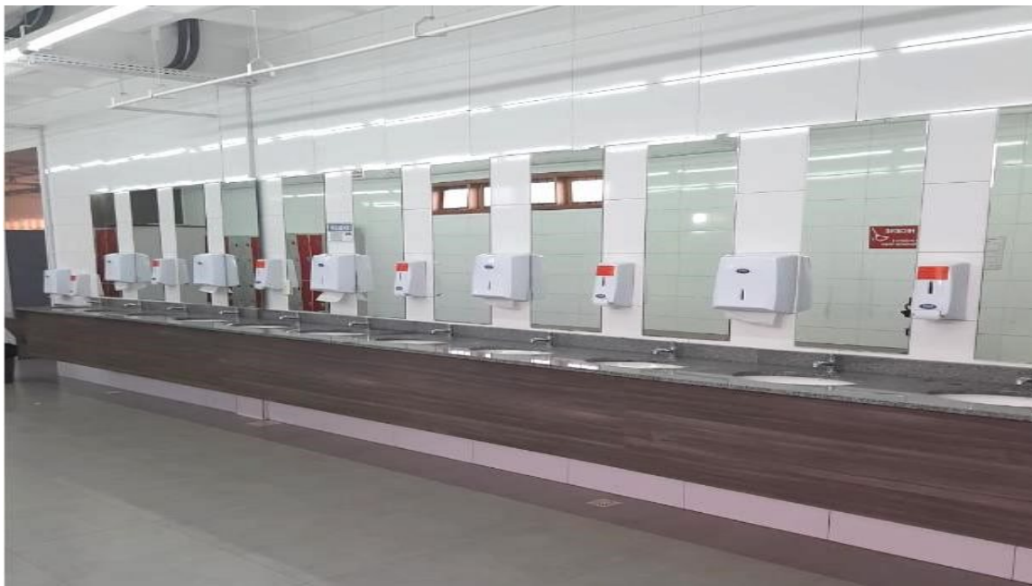
Figura 4 – Banheiros dos vestiários
