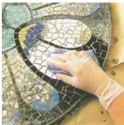
Figura 257: Remoção do excesso de massa e limpeza.
