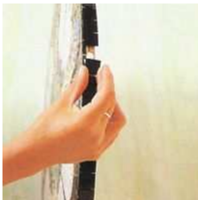
Figura 255: Acabamento nas laterais.
