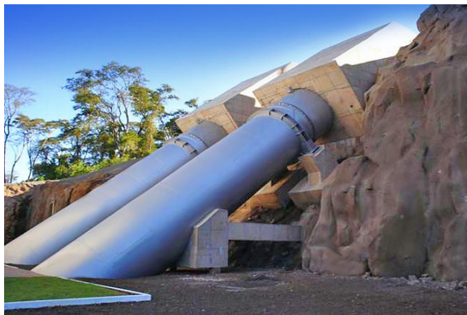
Figura 8 - Exemplo de conduto forçado
