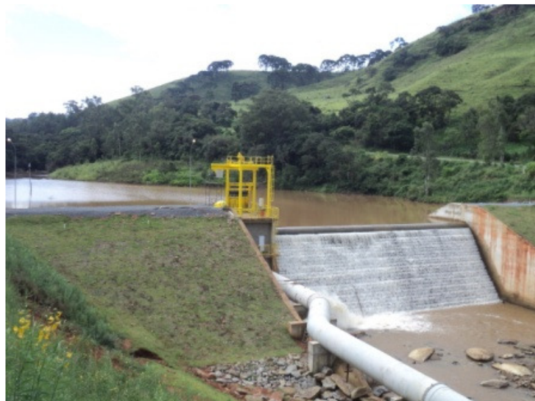
Figura 7 – Exemplo de barramento
