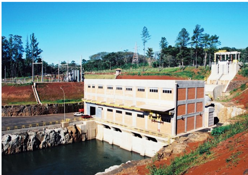
Figura 5 - Vista externa da casa de força
