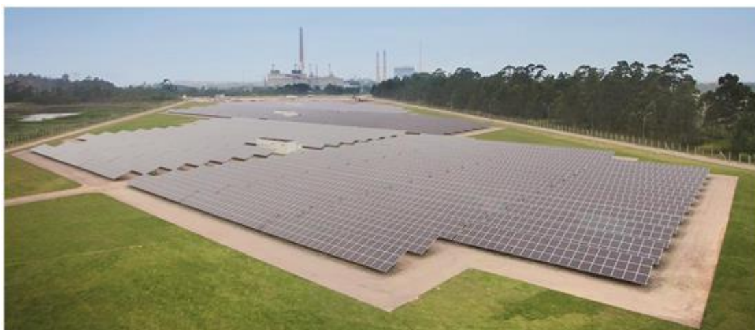
Figura 3 - Usina localizada em Tubarão\SC
