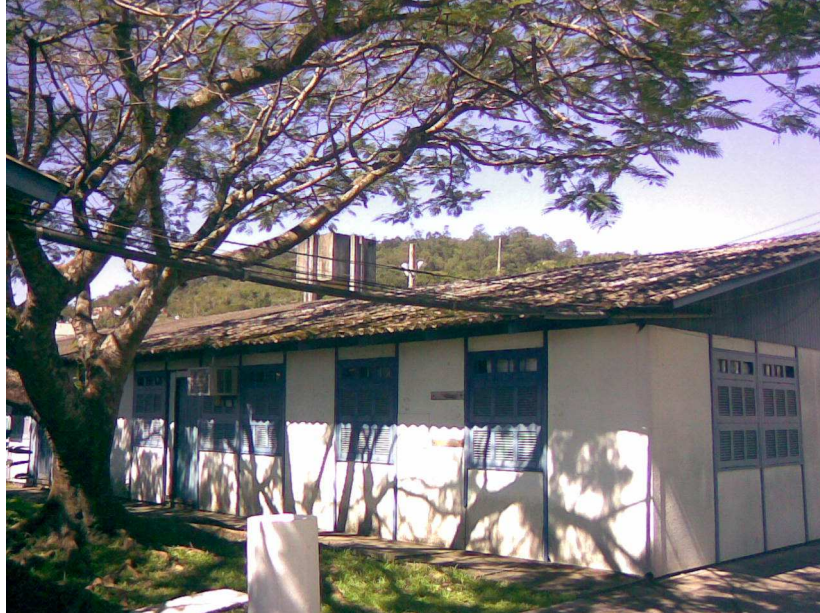
Figura 3-3: Edificação com estrutura de madeira
