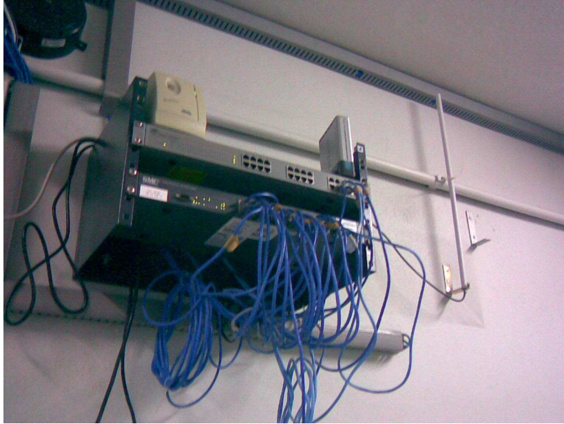
Figura 3-7: Exemplo de um dos access points irregulares
